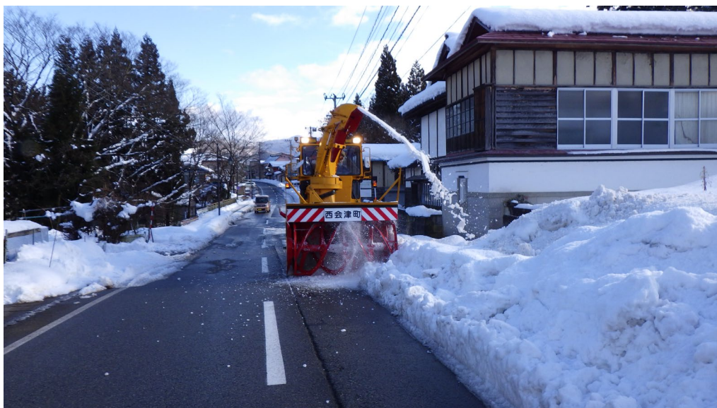
[道路除雪：野沢地区]
