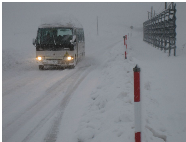
[防雪柵：尾野本地区]
